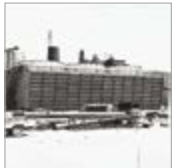
東洋一の冷却塔（当時）
