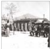
新日本建設工業㈱ 設立地鎮祭
