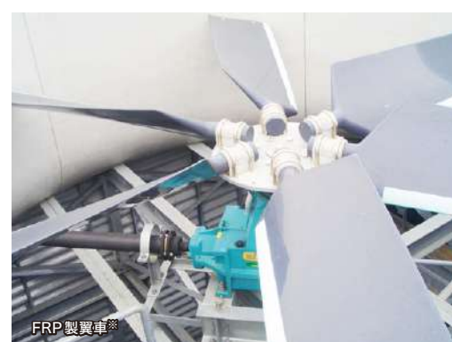
※翼車：翼とハブを組み合わせたもの
