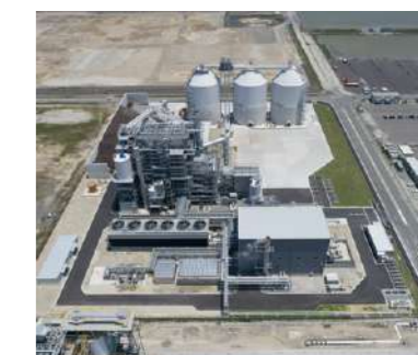
発電設備（復水器冷却）
