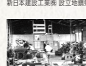
冷却塔送風機製作
